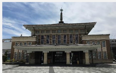
奈良市総合観光案内所 築：昭和9年 もともとはJR奈良駅舎として建てられた。高架化に伴い、現在の場所に移動され、観光案内所として活用しています。
